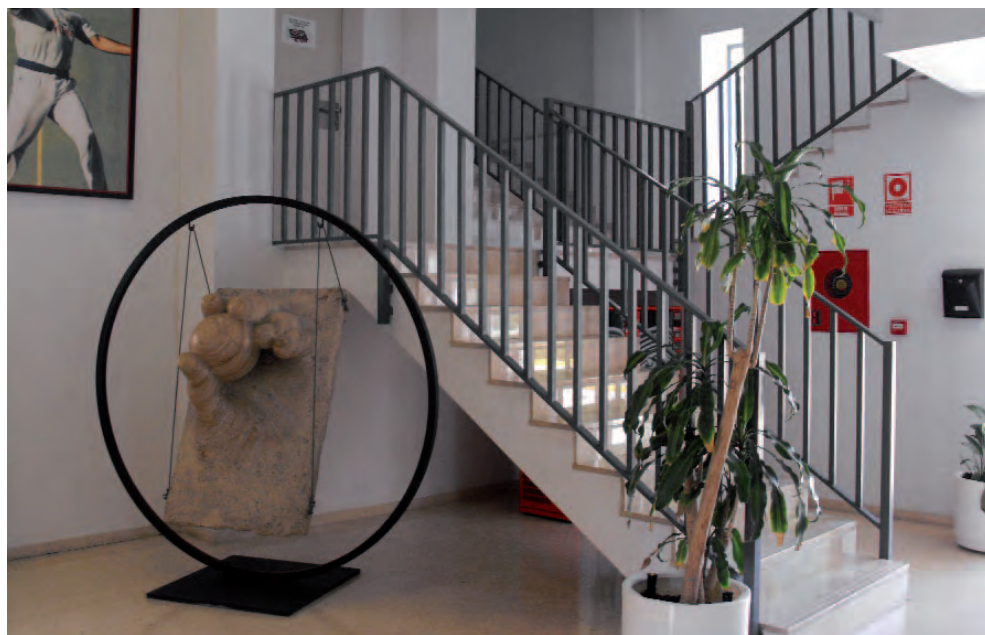
Acceso mediante escalera.
