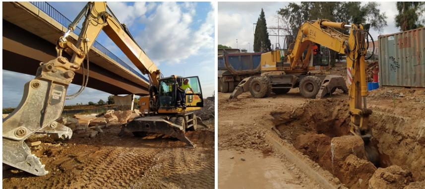
Figura 4. Retroexcavadora giratoria. Fuente: estudio de campo.
