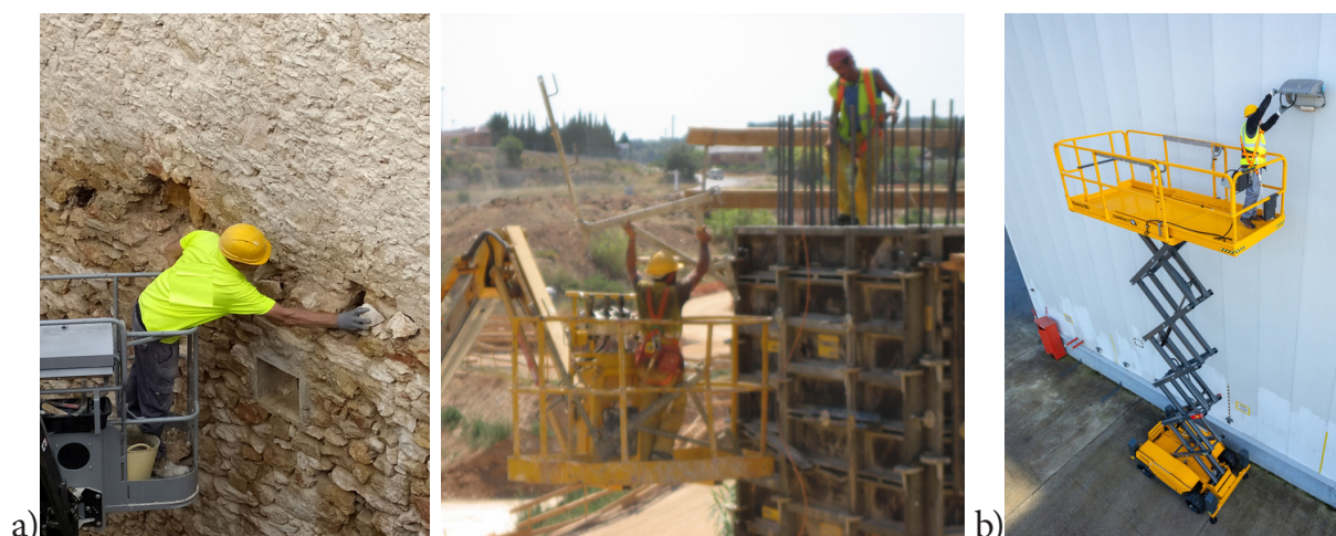
Figura 102 – Posturas forzadas por un ajuste o uso incorrecto de la cesta
