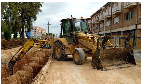
Figura 5. Retroexcavadora mixta. Fuente: estudio de campo.
