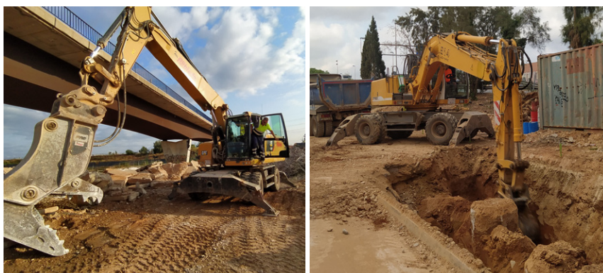
Figura 4. Retroexcavadora giratoria. Fuente: estudio de campo.
