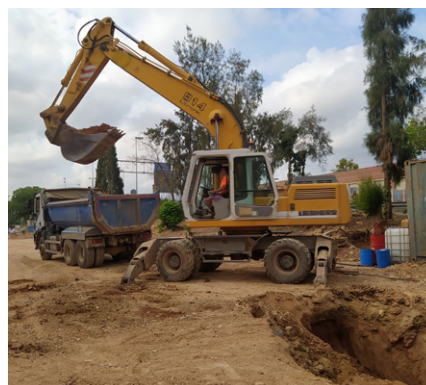
Figura 3. Retroexcavadora giratoria. Fuente: estudio de campo.
